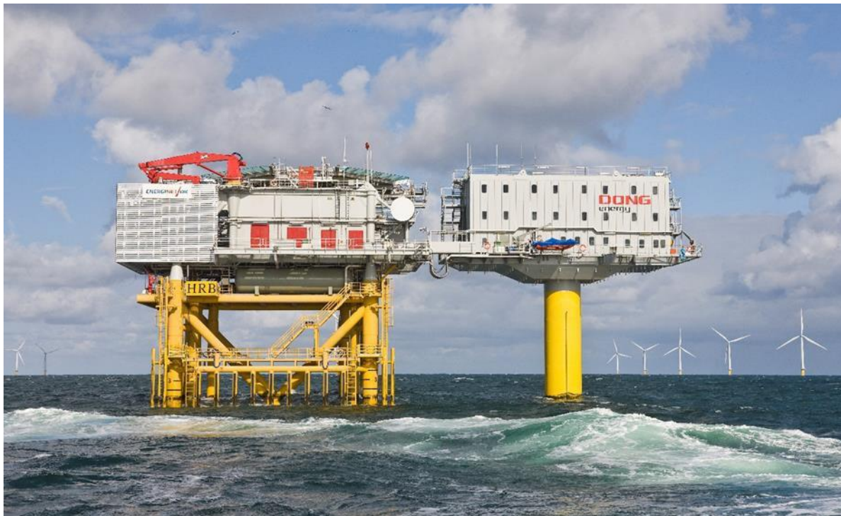
Figur 3-8 Exempel på plattform för logi (höger) vid Horns Rev 2 havsbaserad vindkraft, bredvid ligger en transformatorstation (vänster). Plattformen för logi är grundlagd på monopilefundament och transformatorstationen med en fackverkskonstruktion.
