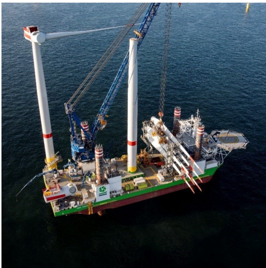
Figur 5-1 Installation av turbin med semi-jack-up fartyg. (Foto: Ørsted)
