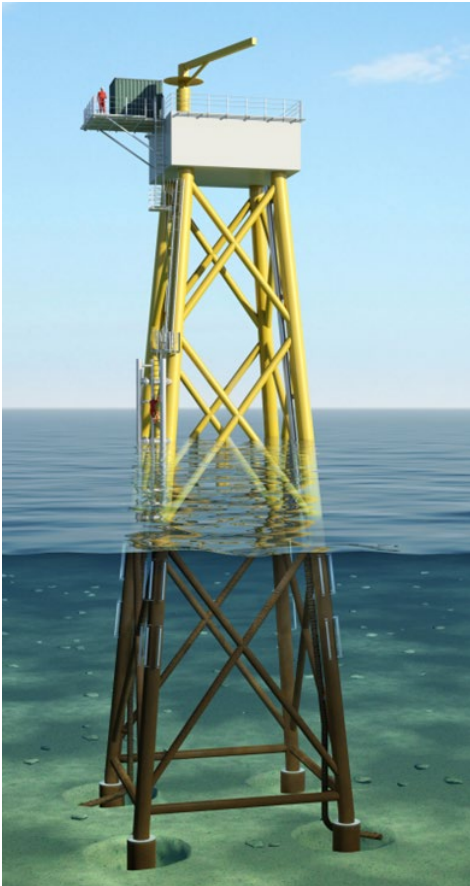
Figur 4-5 Fackverksfundament med tillhörande övergångsstycke (Illustration: Ramboll).
