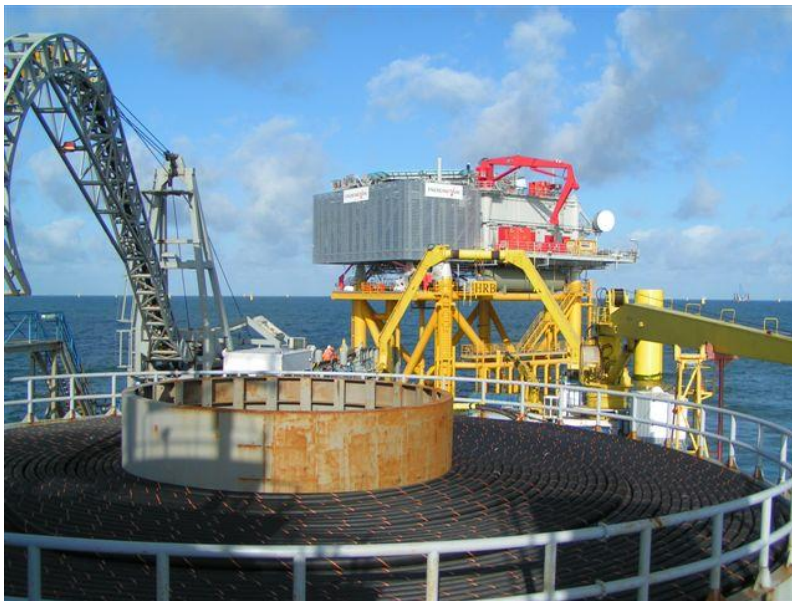
Figur 4-2 Installation av kablar från kabellägningsfartyg vid Anholt (Foto: Ramboll).
