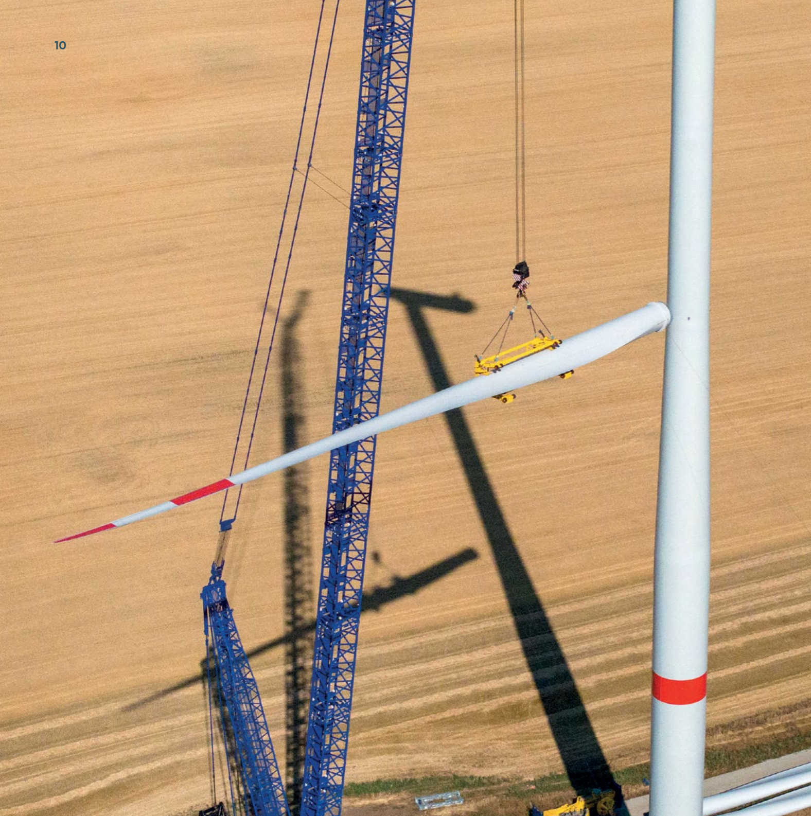
📍 Bau des Windparks Wansleben Repowering II im Jahr 2023, Landkreis Mansfeld-Südharz, Sachsen-Anhalt.
