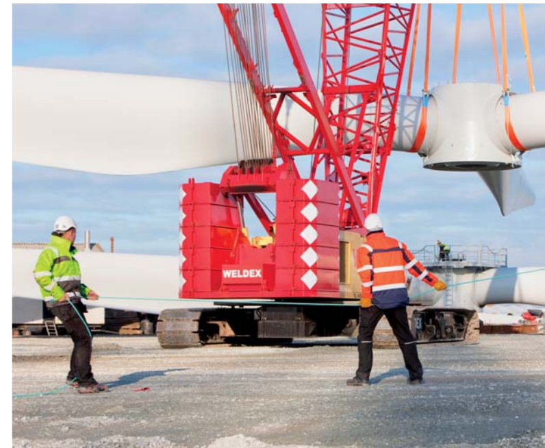
Teknikere klargør en havvindmølle til installation.
