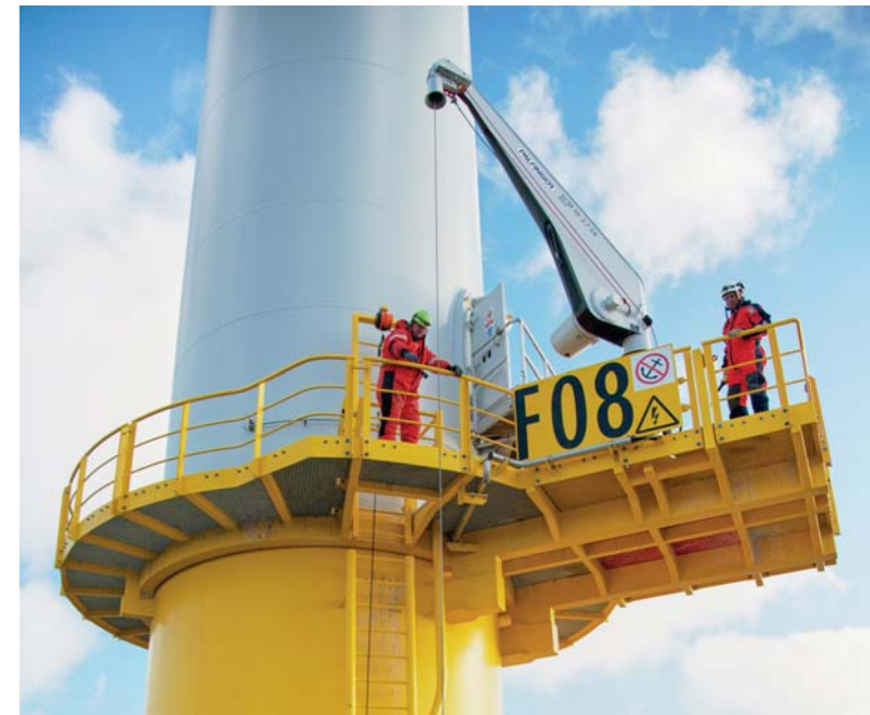
Arbejdspladsen for de vindmølleteknikere, som vedligeholder møllerne, ligger ude i Kattegat og i op til 82 meters højde. Derfor er det vigtigt at medbringe det rigtige værktøj og de rigtige reservedele første gang. Teknikerne arbejder i teams og har en fast plan for service og inspektion.
