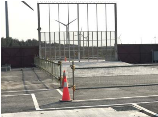
工區出入口設置洗車台(作業中)
