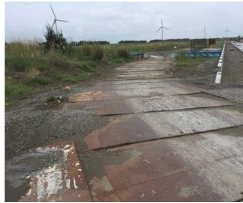
架設鋼板抑制粉塵
