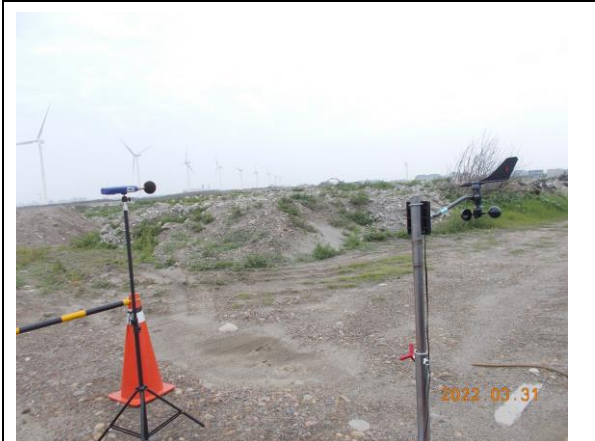
營建噪音：陸纜工地周界(111.03.31)
