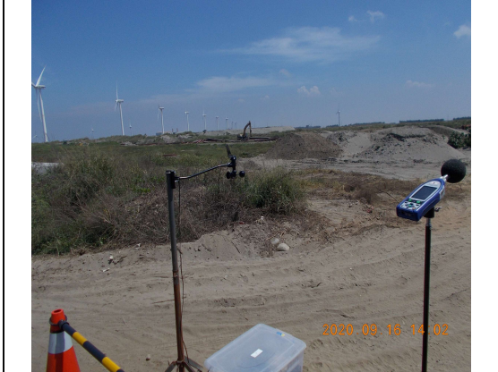
營建噪音：陸纜工地周界(109.09.16)
