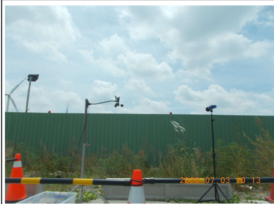
營建噪音：陸域自設升(降)壓站工地周界(109.07.03)
