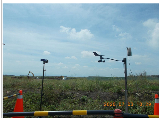
營建噪音：陸纜工地周界(109.07.03)
