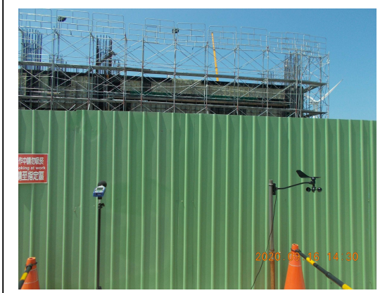
營建噪音：陸域自設升(降)壓站工地周界(109.09.16)
