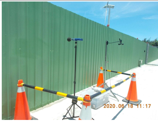
營建噪音：陸域自設升(降)壓站工地周界(109.06.18)
