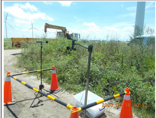
營建噪音：陸纜工地周界(109.06.18)
