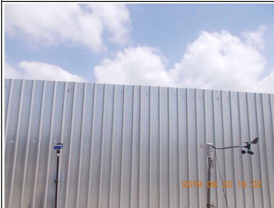
營建噪音：陸域自設升(降)壓站工地周界(108.09.20)
