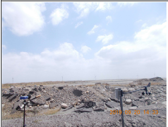
營建噪音：陸纜工地周界(108.09.20)
