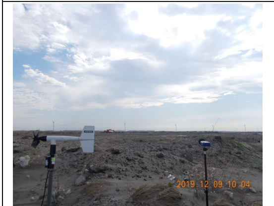
營建噪音：陸纜工地周界(108.12.09)
