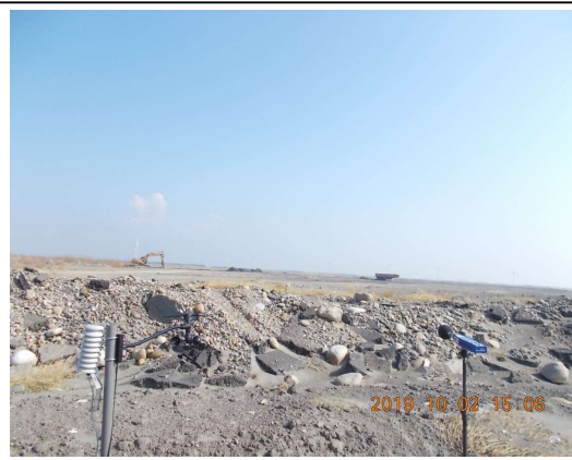
營建噪音：陸纜工地周界(108.10.02)
