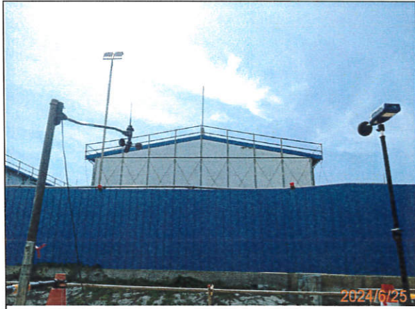
營建噪音：陸域自設升(降)壓站工地周界(113.06.25)
