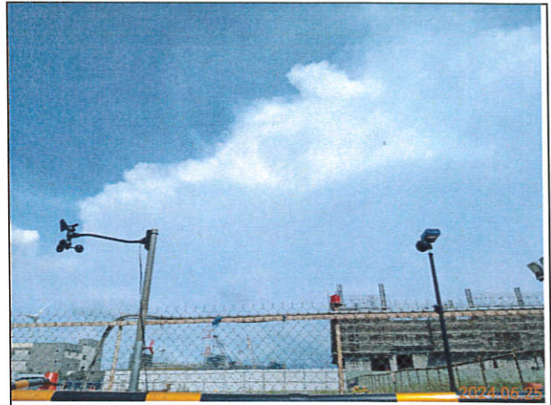
營建噪音：陸纜工地周界(113.06.25)
