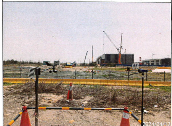
營建低頻噪音：陸纜工地周界(113.04.17)
