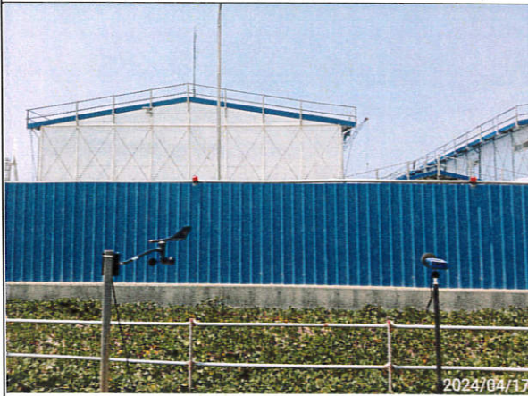
營建噪音：陸域自設升(降)壓站工地周界(113.04.17)
