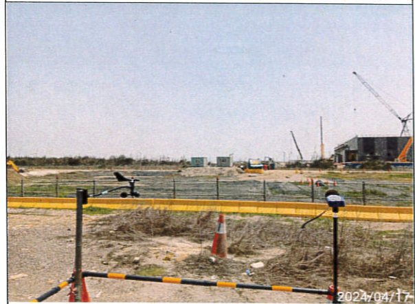
營建噪音：陸纜工地周界(113.04.17)
