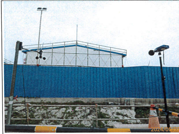
營建噪音：陸域自設升(降)壓站工地周界(113.05.23)
