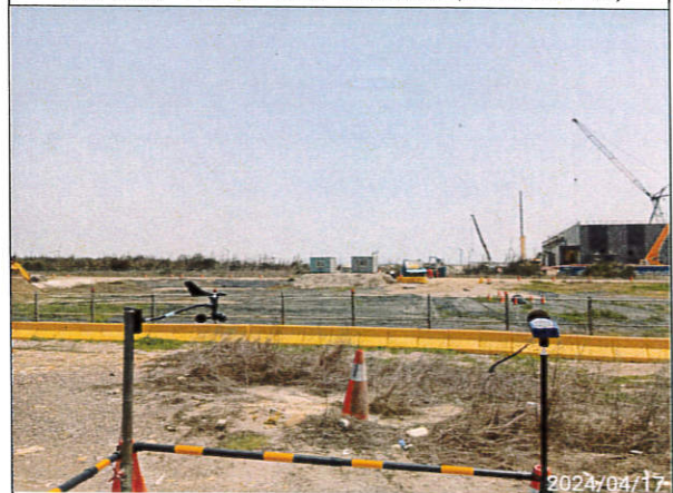
營建噪音：陸纜工地周界(113.04.17)
