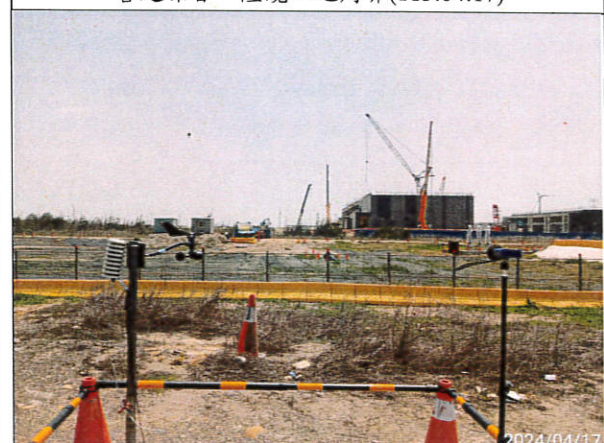
營建低頻噪音：陸纜工地周界(113.04.17)
