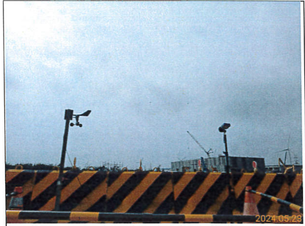
營建噪音：陸纜工地周界(113.05.23)
