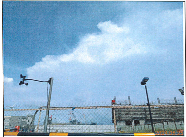
營建噪音：陸纜工地周界(113.06.25)
