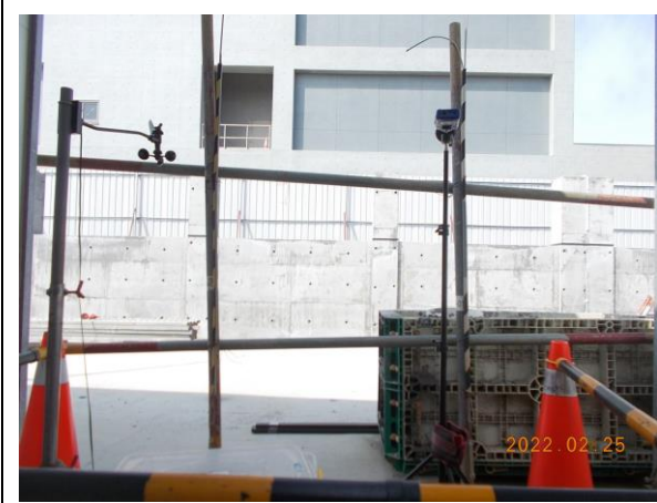
營建噪音：陸域自設升(降)壓站工地周界(111.02.25)
