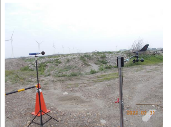
營建噪音：陸纜工地周界(111.03.31)
