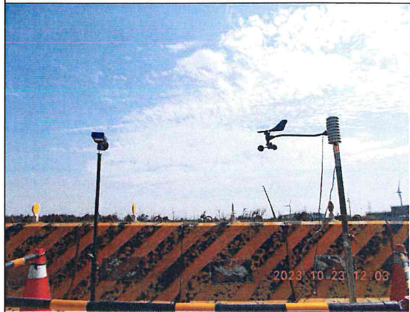
營建低頻噪音：陸纜工地周界(112.10.23)
