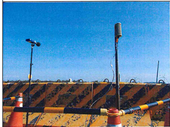
營建低頻噪音：陸纜工地周界(112.11.27)
