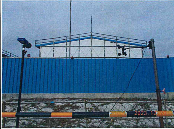
營建噪音：陸域自設升(降)壓站工地周界(112.12.20)
