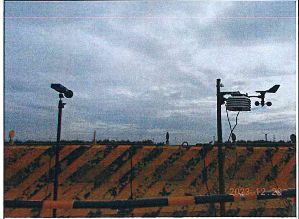
營建低頻噪音：陸纜工地周界(112.12.20)
