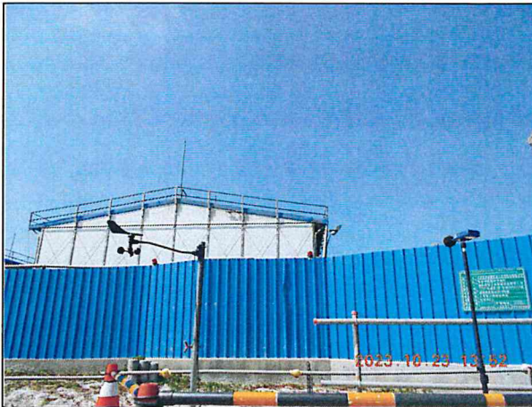
營建噪音：陸域自設升(降)壓站工地周界(112.10.23)
