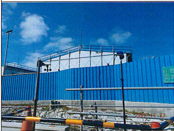
營建噪音：陸域自設升(降)壓站工地周界(112.11.27)
