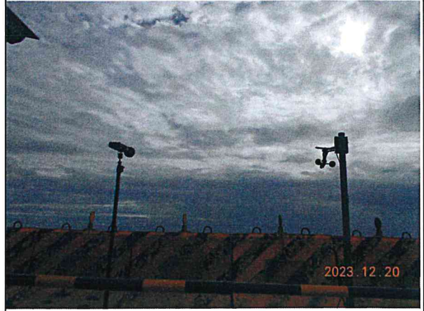
營建噪音：陸纜工地周界(112.12.20)
