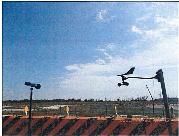
營建噪音：陸纜工地周界(112.10.23)
