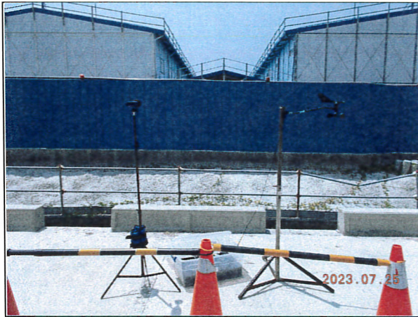
營建噪音：陸域自設升(降)壓站工地周界(112.07.25)
