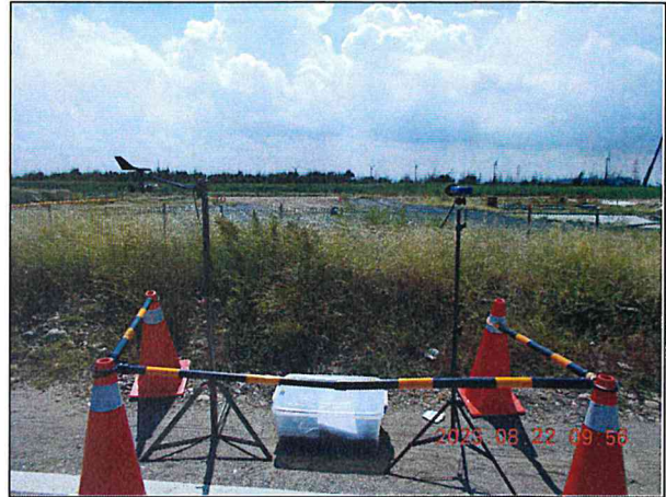
營建噪音：陸纜工地周界(112.08.22)
