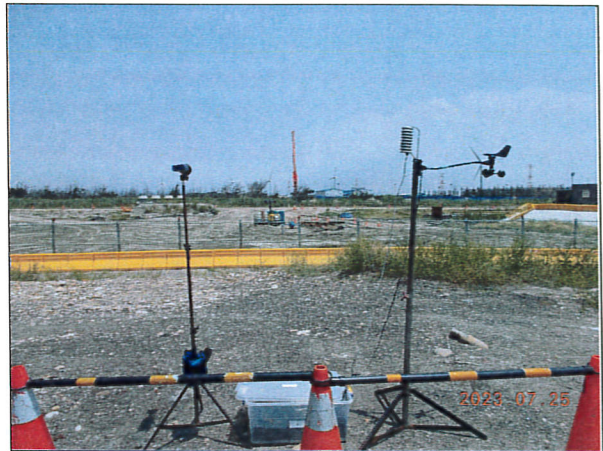
營建噪音：陸纜工地周界(112.07.25)
