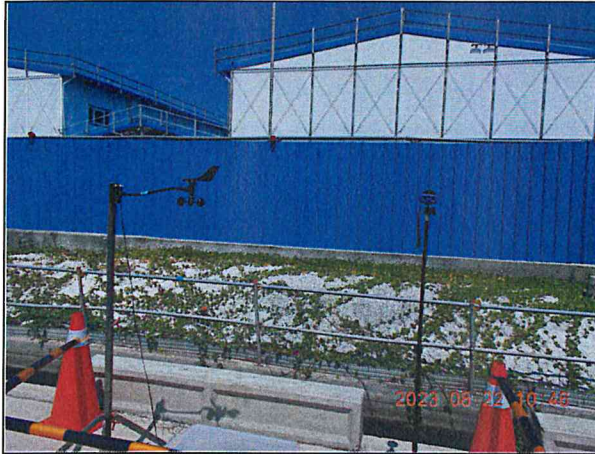
營建噪音：陸域自設升(降)壓站工地周界(112.08.22)
