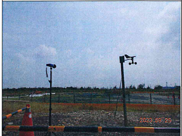
營建噪音：陸纜工地周界(112.09.25)
