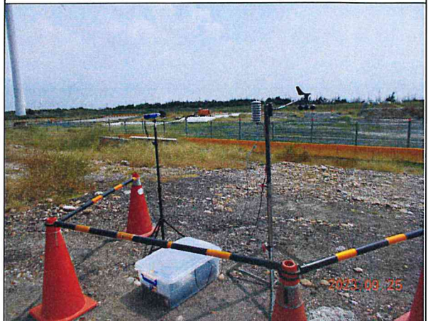
營建低頻噪音：陸纜工地周界(112.09.25)
