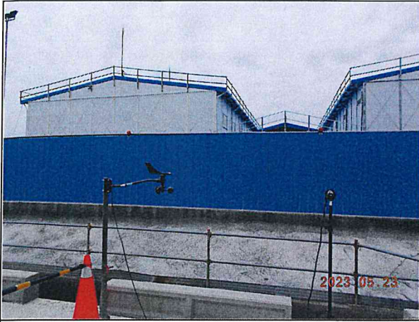
營建噪音：陸域自設升(降)壓站工地周界(112.05.23)
