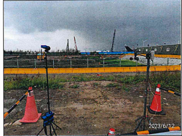
營建噪音：陸纜工地周界(112.06.12)
