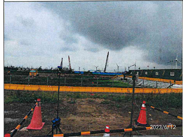
營建低頻噪音：陸纜工地周界(112.06.12)
