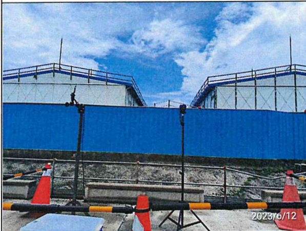
營建噪音：陸域自設升(降)壓站工地周界(112.06.12)
