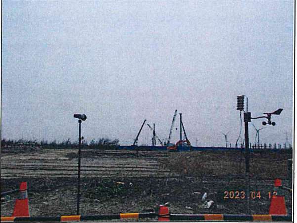
營建低頻噪音：陸纜工地周界(112.04.12)
