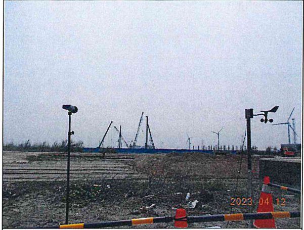
營建噪音：陸纜工地周界(112.04.12)
