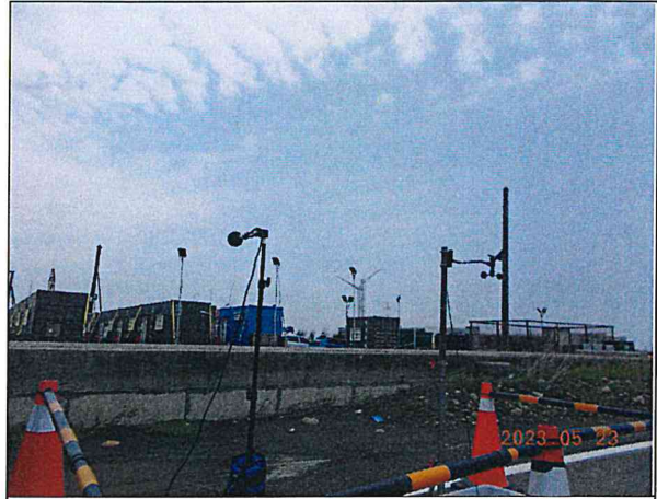
營建噪音：陸纜工地周界(112.05.23)
