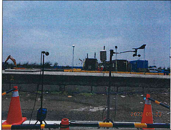
營建低頻噪音：陸纜工地周界(112.05.23)
