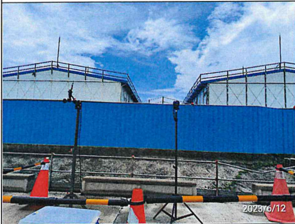
營建噪音：陸域自設升(降)壓站工地周界(112.06.12)
