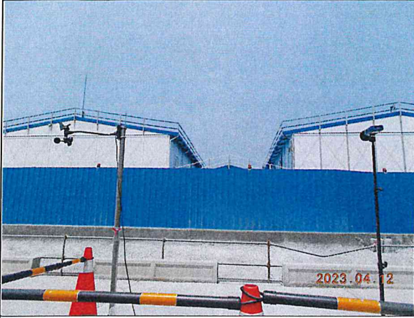
營建噪音：陸域自設升(降)壓站工地周界(112.04.12)
