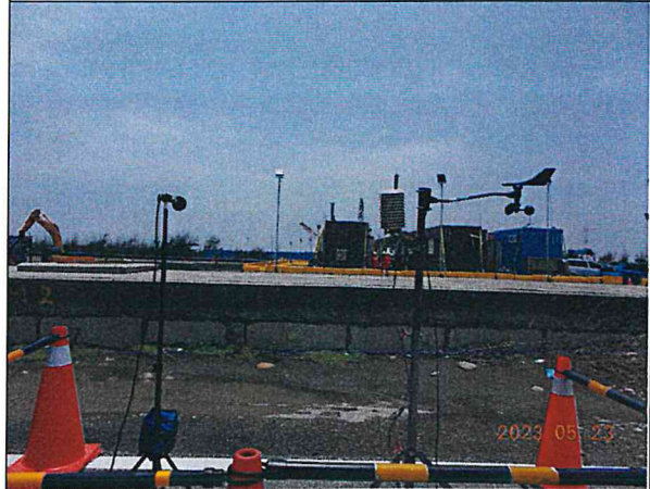
營建低頻噪音：陸纜工地周界(112.05.23)
