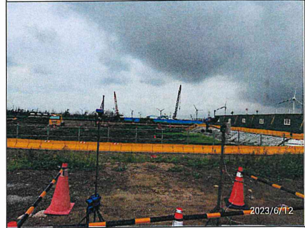
營建低頻噪音：陸纜工地周界(112.06.12)
