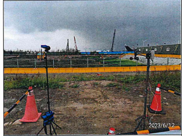
營建噪音：陸纜工地周界(112.06.12)
