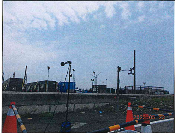
營建噪音：陸纜工地周界(112.05.23)
