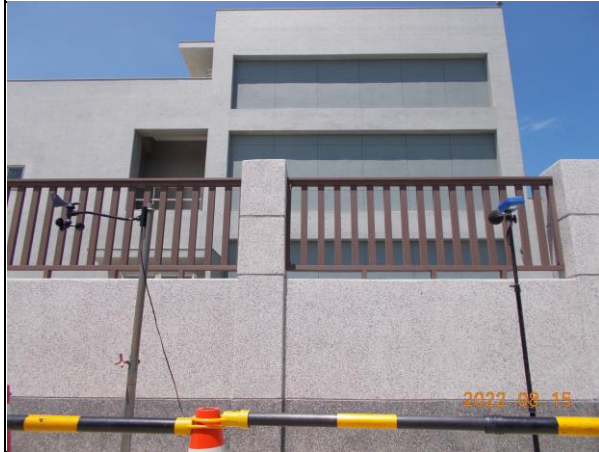
營建噪音：陸域自設升(降)壓站工地周界(111.08.15)
