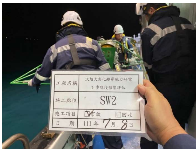
圖 2.6-2 水下噪音儀器 SW-2 現場佈放
