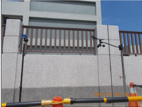
營建噪音：陸域自設升(降)壓站工地周界(111.07.08)
