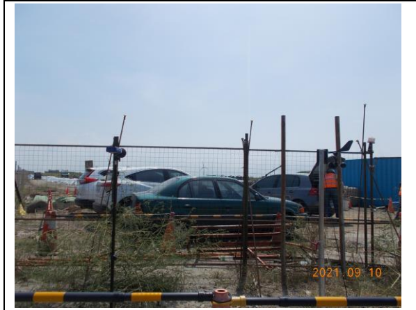
營建噪音：陸纜工地周界(110.09.10)
