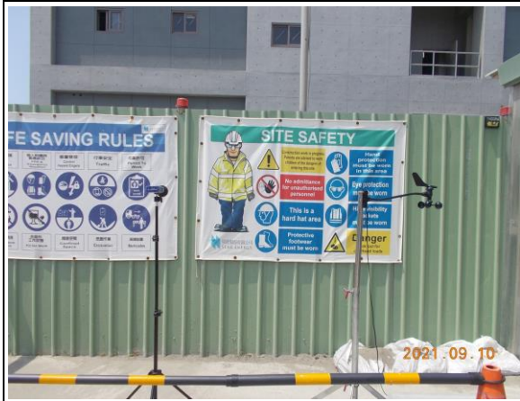
營建噪音：陸域自設升(降)壓站工地周界(110.09.10)
