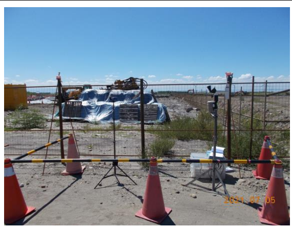
營建噪音：陸纜工地周界(110.07.05)
