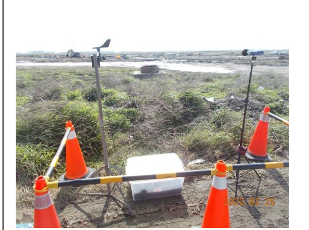
營建噪音：陸纜工地周界(111.02.25)
