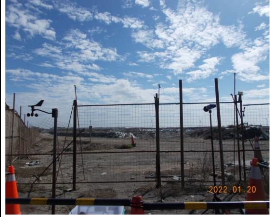
營建噪音：陸纜工地周界(111.01.20)
