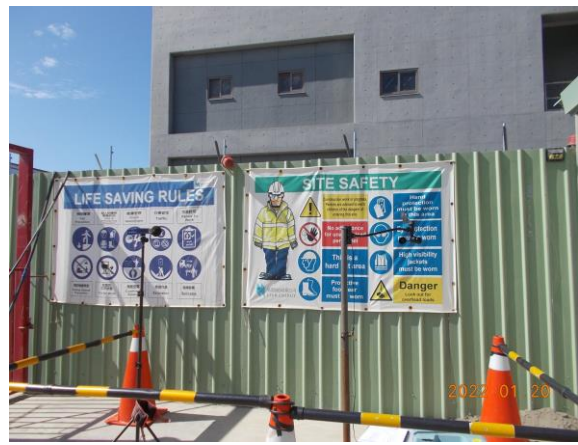
營建噪音：陸域自設升(降)壓站工地周界(111.01.20)
