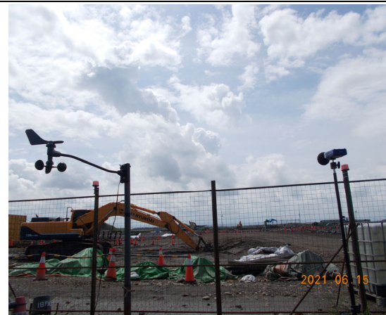
營建噪音：陸纜工地周界(110.06.15)
