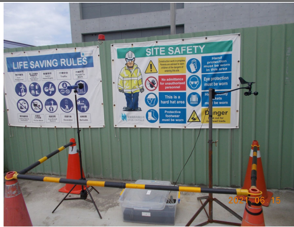
營建噪音：陸域自設升(降)壓站工地周界(110.06.15)
