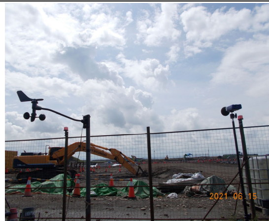
營建噪音：陸纜工地周界(110.06.15)
