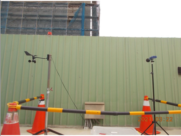
營建噪音：陸域自設升(降)壓站工地周界(110.03.22)
