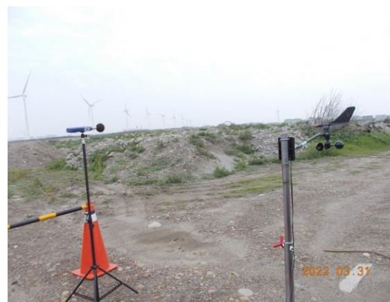
營建噪音：陸纜工地周界(111.03.31)
