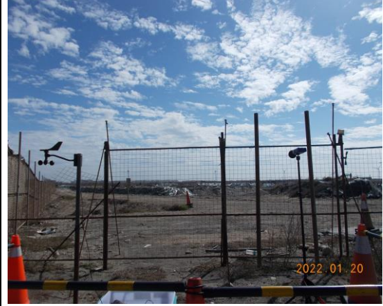
營建噪音：陸纜工地周界(111.01.20)
