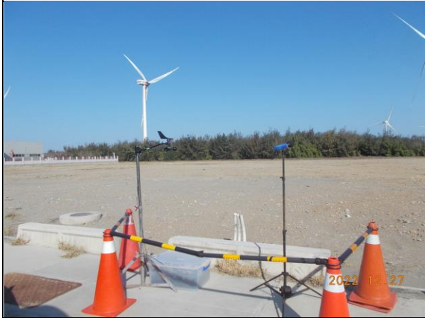
營建噪音：陸域自設升(降)壓站工地周界(111.12.27)
