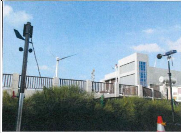
營建噪音：陸域自設升(降)壓站工地周界(111.11.10)
