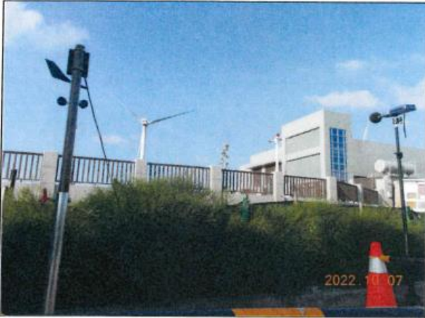
營建噪音：陸域自設升(降)壓站工地周界(111.10.07)
