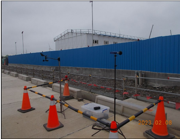
營建噪音：陸域自設升(降)壓站工地周界(112.02.08)
