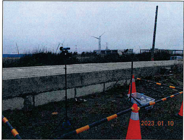
營建噪音：陸纜工地周界(112.01.10)
