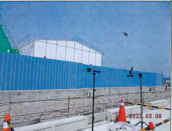
營建噪音：陸域自設升(降)壓站工地周界(112.03.08)
