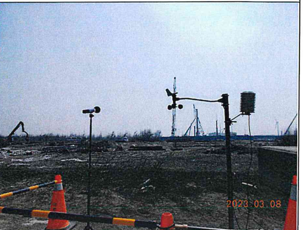
營建低頻噪音：陸纜工地周界(112.03.08)
