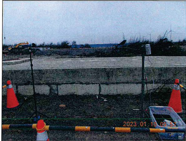
營建低頻噪音：陸纜工地周界(112.01.10)
