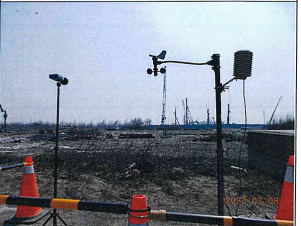
營建噪音：陸纜工地周界(112.03.08)
