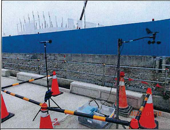
營建噪音：陸域自設升(降)壓站工地周界(112.01.10)
