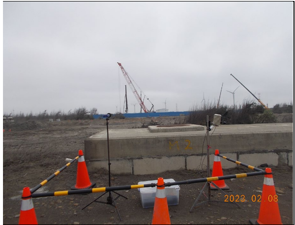
營建噪音：陸纜工地周界(112.02.08)
