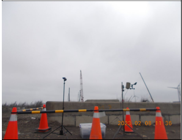
營建低頻噪音：陸纜工地周界(112.02.08)
