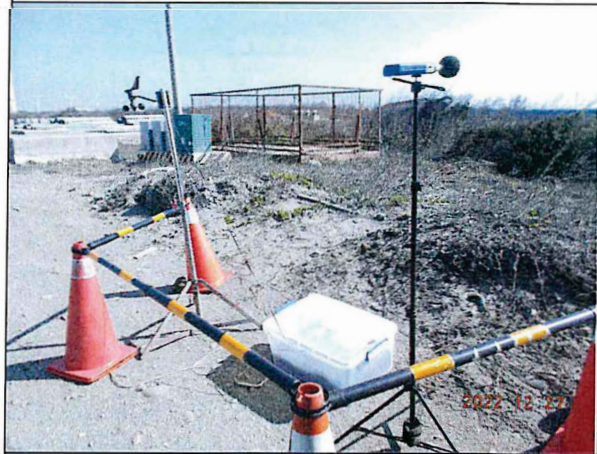
營建噪音：陸纜工地周界(111.12.27)
