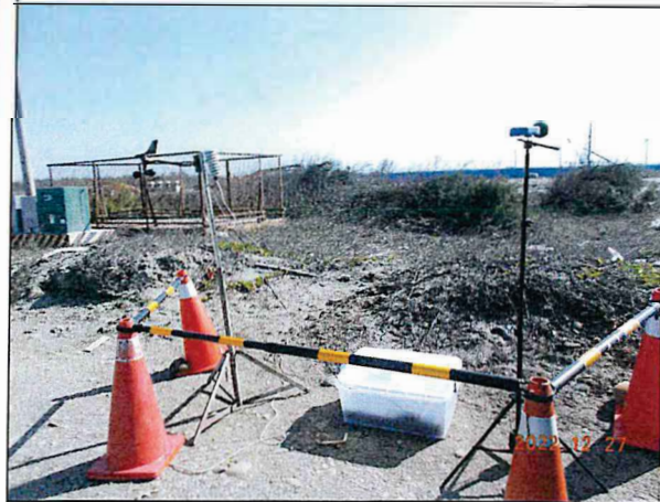
營建低頻噪音：陸纜工地周界(111.12.27)
