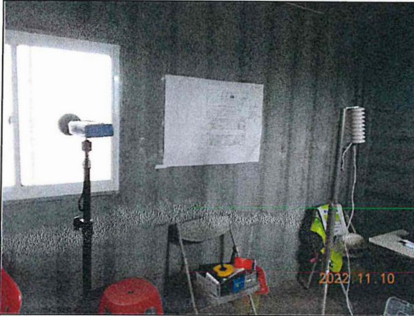
營建低頻噪音：陸域自設升(降)壓站工地周界(111.11.10)
