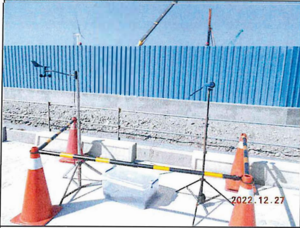
營建噪音：陸域自設升(降)壓站工地周界(111.12.27)
