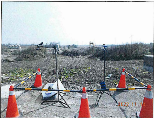
營建噪音：陸纜工地周界(111.11.10)
