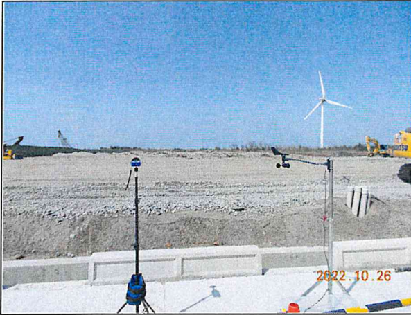
營建噪音：陸域自設升(降)壓站工地周界(111.10.26)
