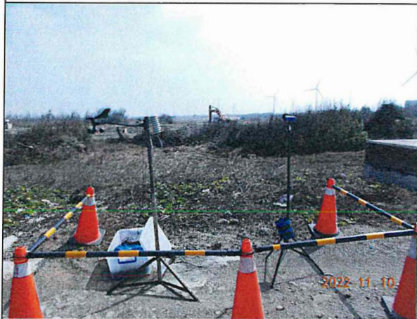
營建低頻噪音：陸纜工地周界(111.11.10)
