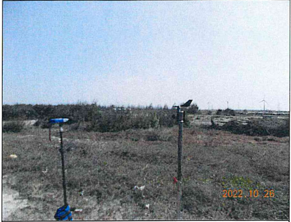
營建噪音：陸纜工地周界(111.10.26)
