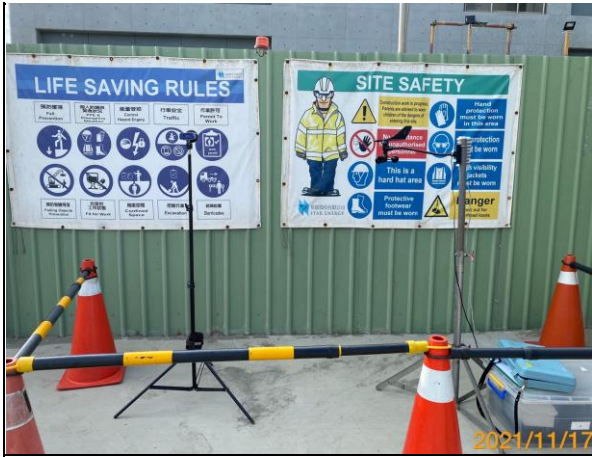
營建噪音：陸域自設升(降)壓站工地周界(110.11.17)
