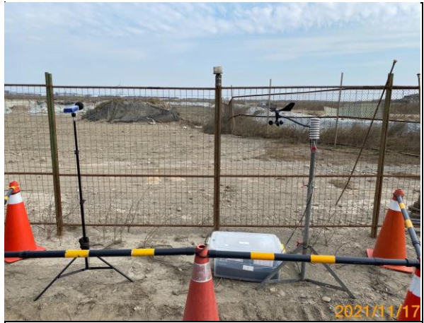
營建噪音：陸纜工地周界(110.11.17)
