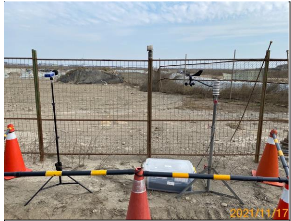
營建噪音：陸纜工地周界(110.11.17)
