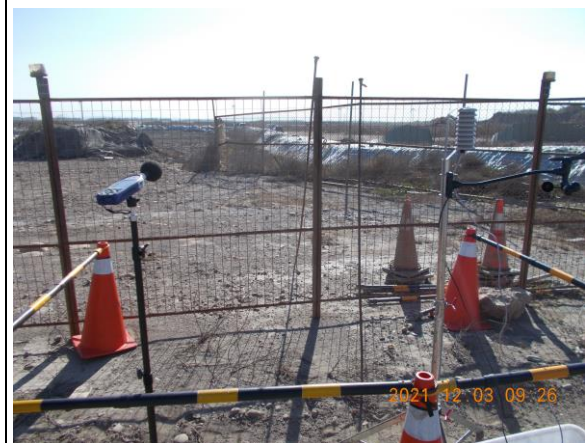
營建噪音：陸纜工地周界(110.12.03)
