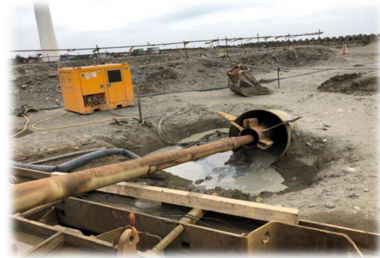
HDD(水平導向式潛鑽)地下工法
