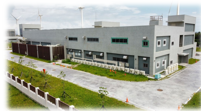
▲ 陸域自設(升)降壓站施作
