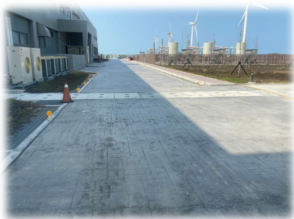
鋪設混凝土抑制粉塵
