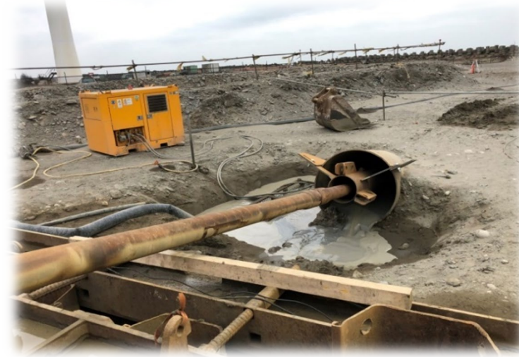
HDD(水平導向式潛鑽)地下工法
