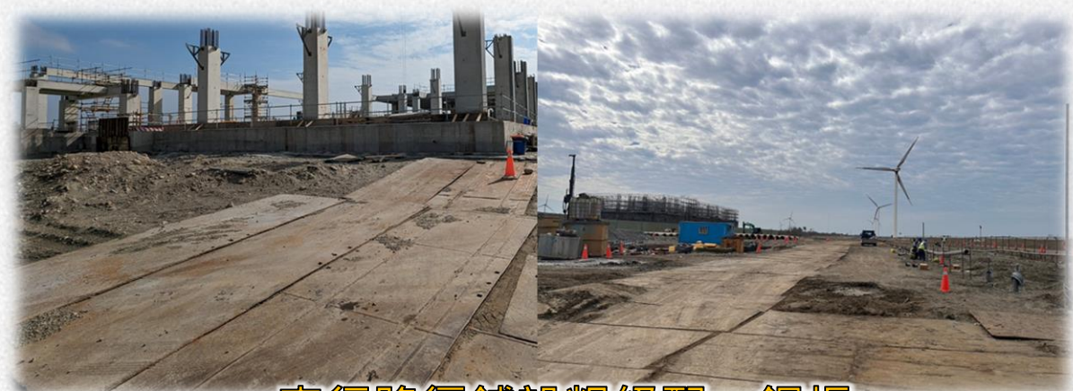
車行路徑鋪設粗級配、鋼板
