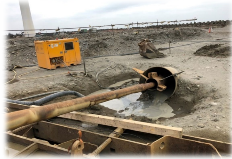
HDD(水平導向式潛鑽)地下工法
