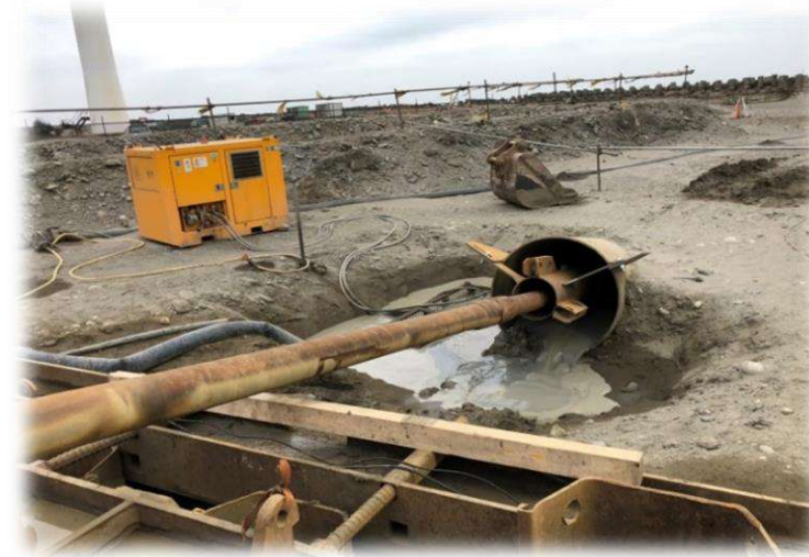
HDD(水平導向式潛鑽)地下工法
