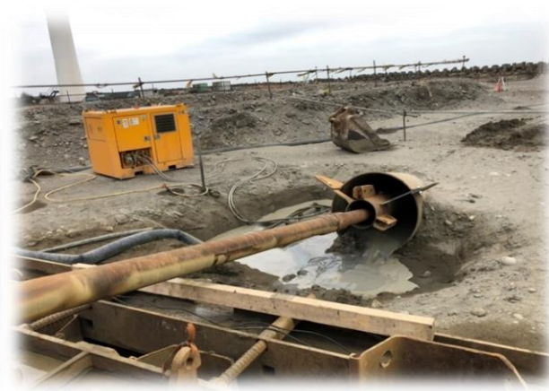
HDD(水平導向式潛鑽)地下工法
