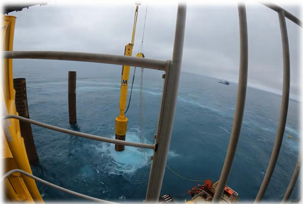
打樁過程全程採用雙層氣泡幕
