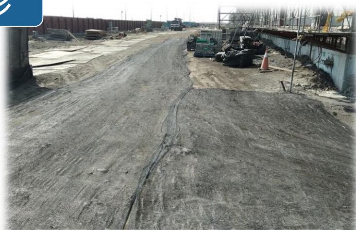
工區裸露地鋪設鋼板/級配/防塵網/混凝土抑制粉塵
