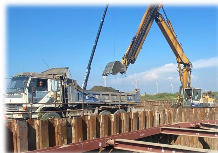
卡車靠近開挖機具減少噪音
