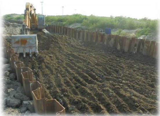
陸纜開挖工程
