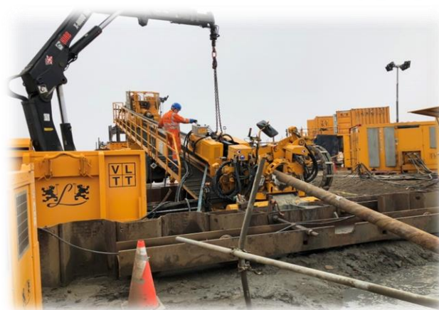
HDD(水平導向式潛鑽)地下工法
