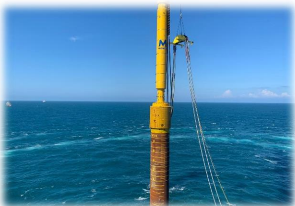
雙層氣泡幕防制工法
