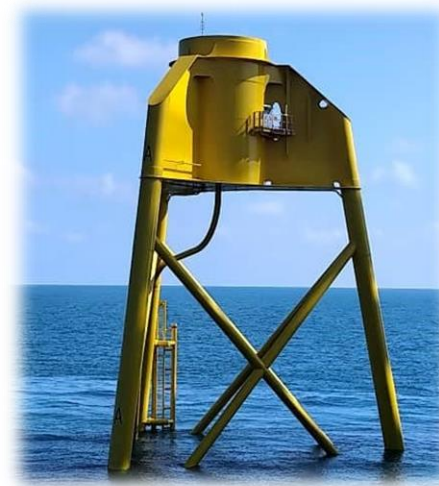
▲ 水下基礎安裝
